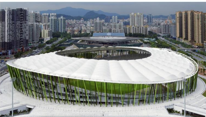
Figure 1: Bao'An Stadium (GMP Architekten)
